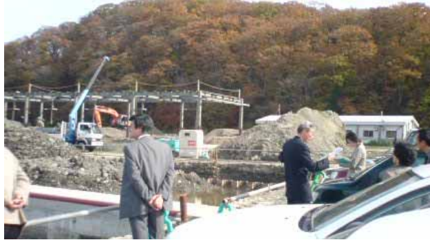
若里漁港に建設中の 養殖作業施設
