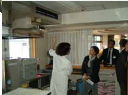
厨房にエアコンが設置された特別養護老人ホーム
