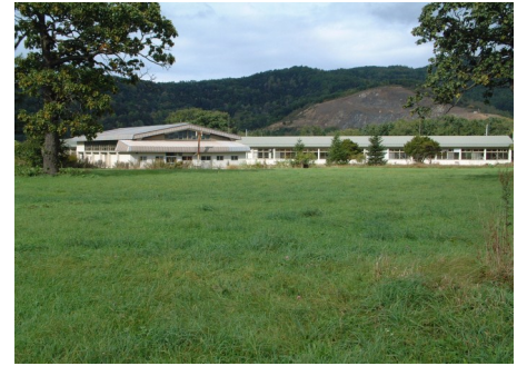
メガソーラー建設候補地(旧若佐小学校)
