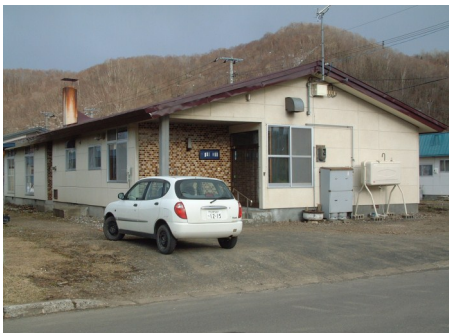
建設から30年以上経過している老人アパート
