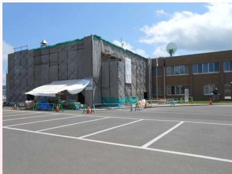
外壁改修工事中の役場庁舎
