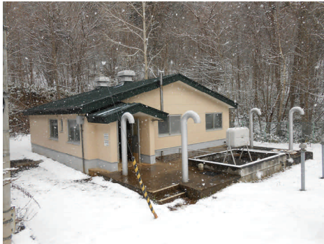
屋根などの塗装が行われた一般廃棄物処理場浸出液処理施設
