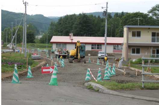
整備が進む若佐保育所前道路
