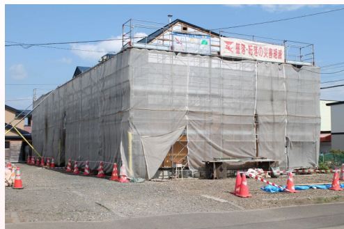
外壁などの改修を行う西富団地
