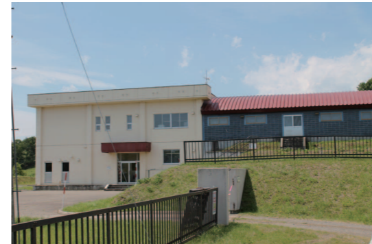
佐呂間簡水浄水場
