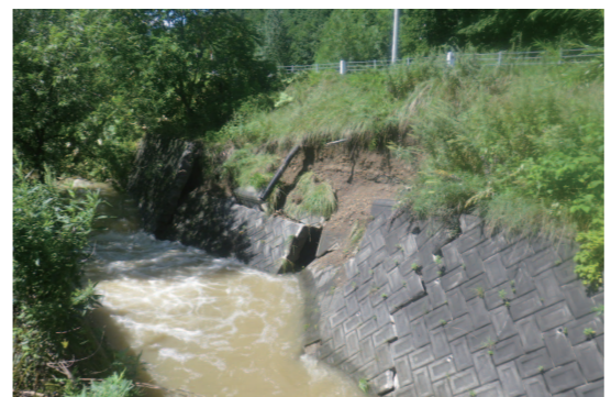
災害復旧を行う共立佐藤の沢川(昨年8月撮影)
