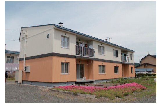
昨年外壁改修を終えた西富団地(8号棟)
