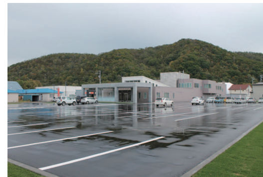
28年度に整備したクリニックさろま駐車場
