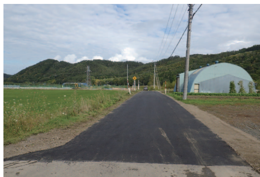
簡易舗装を施したテストコースへの道路
