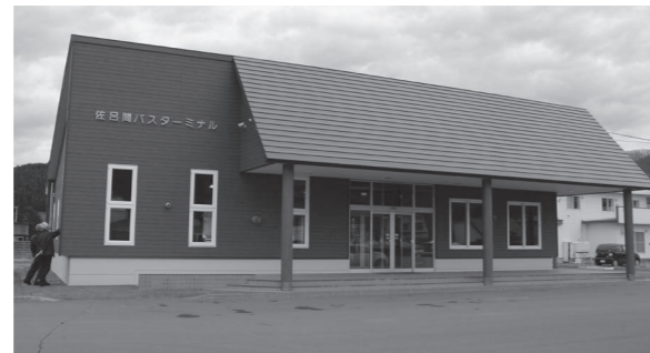
改修により真新しくなったバスターミナル
