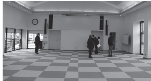
改修された床や天井の状況を視察（佐呂間コミセン）
