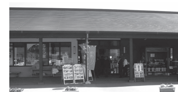
好立地に整備された道の駅「つの」
