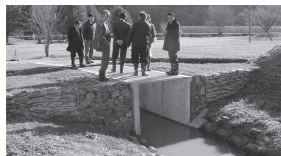
小公園内の管渠を視察（市街地排水処理事業）
