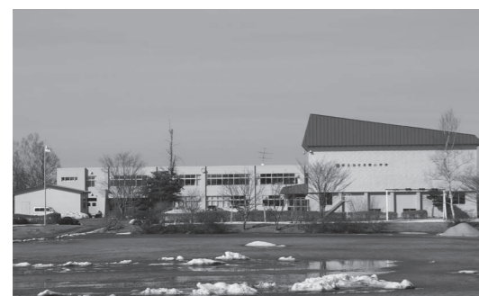
建設後40年が経過する浜佐呂間小学校
