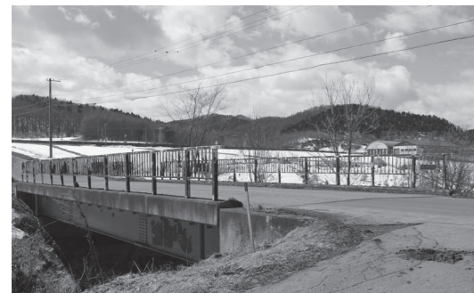
修繕工事が行われる大成6線橋
