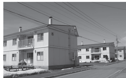
今年度工事が実施される15～17号棟
