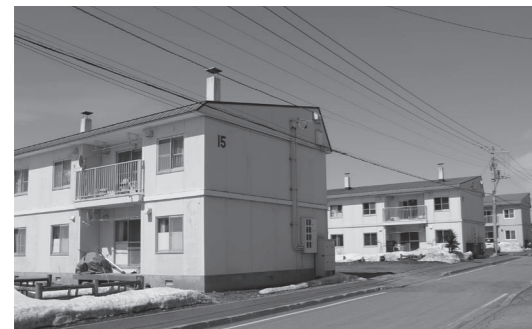
今年度工事が実施される15～17号棟
