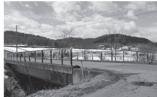
修繕工事が行われる大成6線橋
