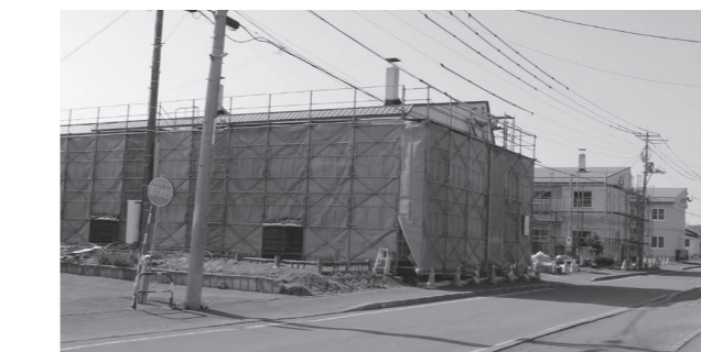
今年度で全ての棟の改修が終了する西富団地
