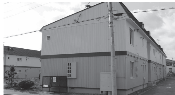
今年度外壁が改修された西富団地 16号棟
