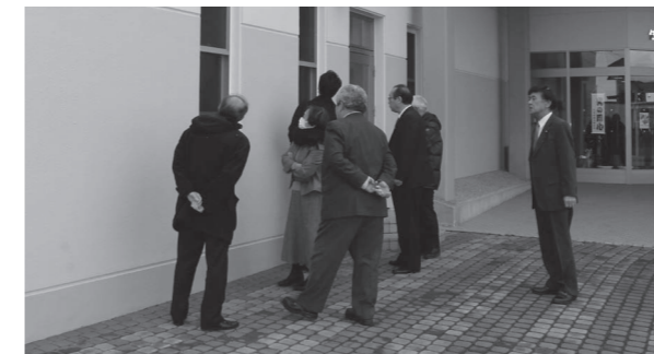
以前より明るい色に塗り替えられた愛の園の外壁
