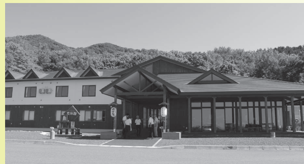
コロナ禍に対応した営業を行うため改修する悠林館
