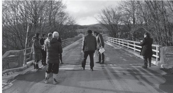
来年度以降に橋面や防護柵の改修が行われる共立橋
