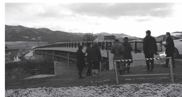
新しい橋が完成し通行が可能になった藤見橋
