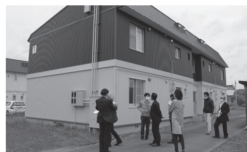
外壁は断熱材を貼り直し、ガルバリウム鋼板張り
