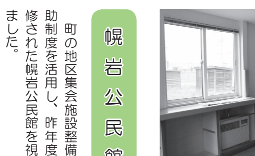
施設内に設置されたエアコン
