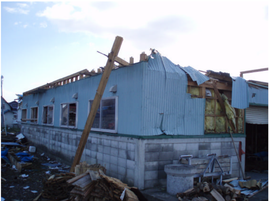
若佐市街地倒壊倉庫全景
